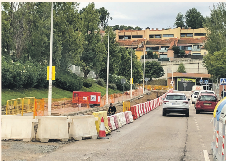
Imagen de las obras a la altura de la calle Garraf
