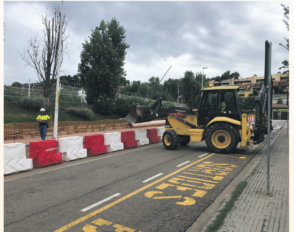
Los trabajos provocan cortes puntuales de circulación
