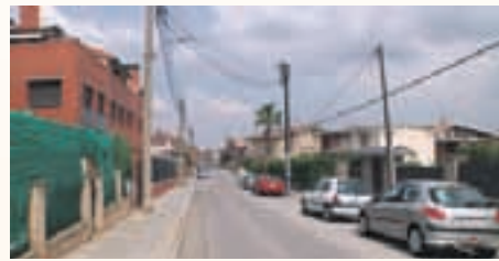
Situación actual de la vía
